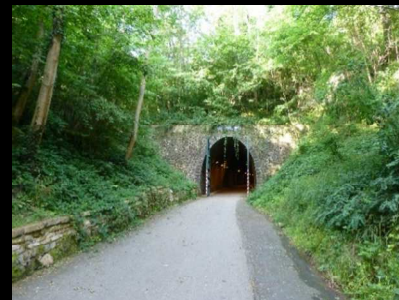
Tunnel du Bois Clair sur la voie verte
